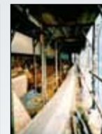
Erwärmung großer Fassadenflächen mit perforierten Spezial-Schlauch- folien z.B. zur Aufbringung von Wärmeverbundsystemen im Winter etc.
