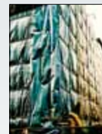
Erwärmung großer Fassadenflächen mit perforierten Spezial-Schlauch- folien z.B. zur Aufbringung von Wärmeverbundsystemen im Winter etc.
