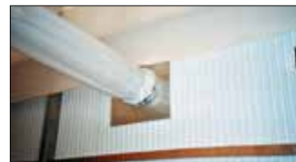
Optimale Wärmeverteilung in langen Messezelten durch Einsatz perforierter Spezial-Schlauchfolien
