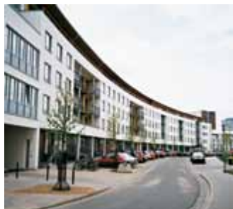
Beheizung einer Neubauwohnanlage. Installierte Gesamtheizleistung: 910 KW
