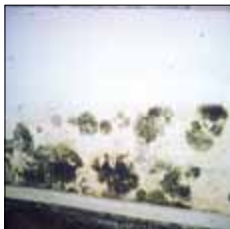
Schimmelbildung über der Fußleiste, verursacht durch Bodenfeuchtigkeit nach Wasserschaden
