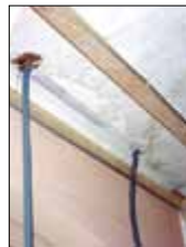
Trocknung einer Einschub-Holzbalkendecke
